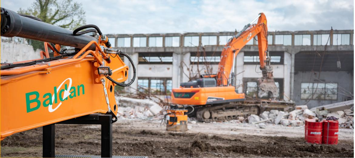
Completate le opere preliminari, Baldan ha cominciato a demolire casematte, bunker e tunnel procedendo per quadranti, in modo da poter contestualmente lavorare in parallelo con le opere di sbancamento e livellazione del terreno destinato a ospitare le strutture dei pannelli solari.
